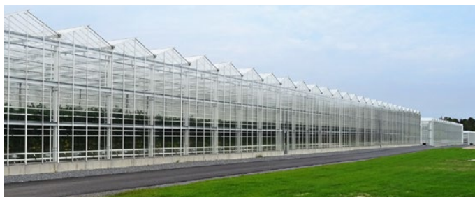
Peckas Naturodlingar odlar fisk och tomater året runt i en modern akvaponi bestående av en fiskbassäng och ett växthus där fisken ger näring till växterna och växterna renar vattnet.
